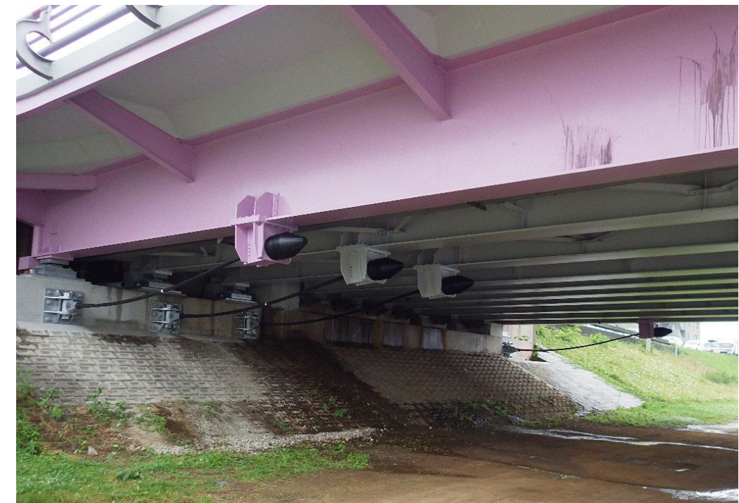
図表2-1-19 橋りょうの耐震化(新己斐橋 落橋防止装置の設置)
